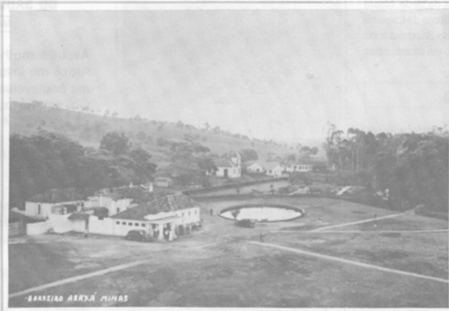
Antigo Barreiro, vendo-se a Fonte Andrade Junior. A sub-estação de eletricidade e o Hotel das Fontes. Arquivo SPH FCCB/00315
